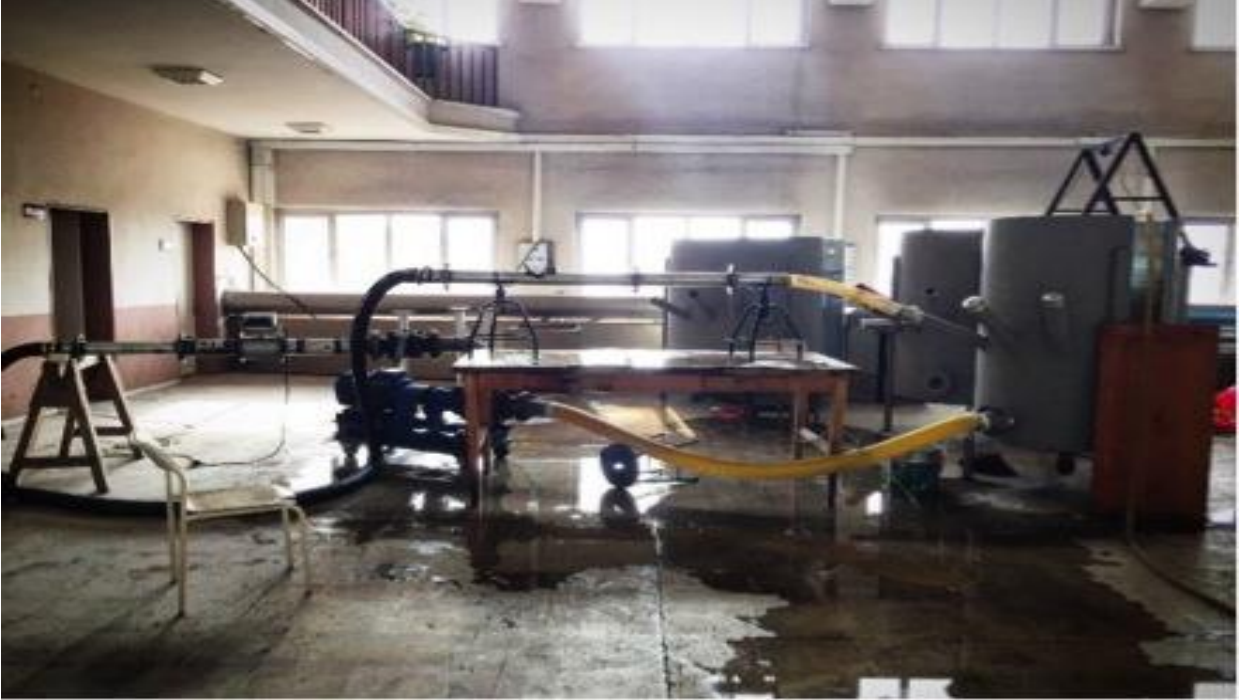
Resim 2. Konduit deney çalışması
